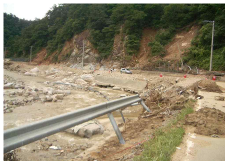
[그림 3-27] 도로, 옹벽 유실 (인제군 가리산천)
