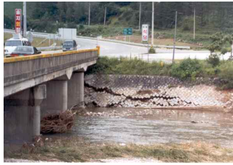
[그림 3-7] 교대부근 석축 유실
