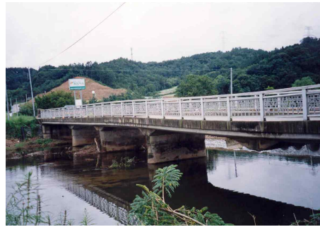
[그림 3-9] 교각 유실
