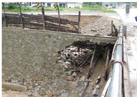
[그림 3-26] 동산동교의 접속부 제방 유실 (강원도 평창군 용평면 계천평)
