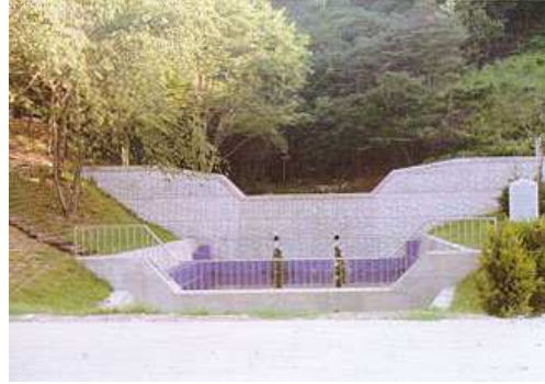
[그림 2-12] 콘크리트 사방담 본담과 부담
