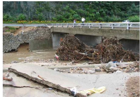
[그림 3-25] 교각에 부유물 집적 및 교량 주변 침수 (강원도 평창군 용평면)
