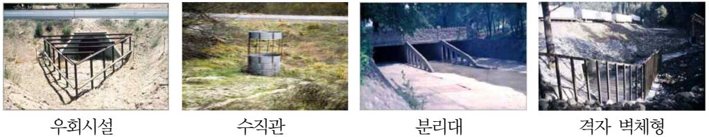
[그림 2-22] 토석류 및 유송잡물 차단시설 설치 사례
