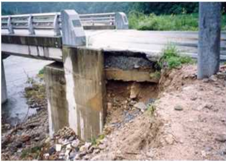
[그림 3-12] 뒤채움재 유실
