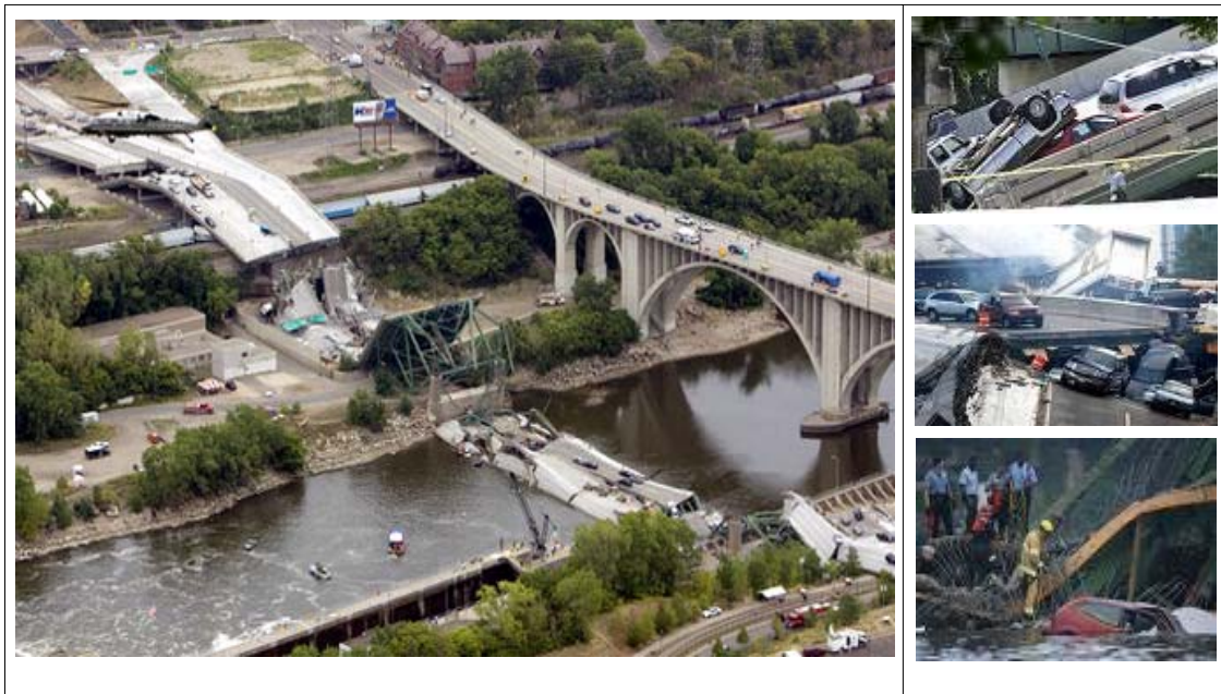
(그림 3) 「I-35W 미시시피강 교량」 붕괴사고 현장에서의 피해차량과 운전자 구조 활동
