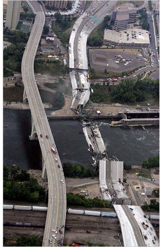
Fig. 3 붕괴 후 전경
