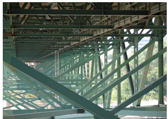
Fig. 2 붕괴전 미네아폴리스 I35W 교량 하부 전경
