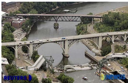
Fig. 5 붕괴된 I-35W 미시시피강 교량(No.9340)
