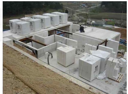
(국내 ALC 시공 사례)
